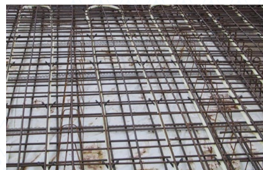
Beispiel: Rohrbefestigung auf der oberen Bewehrung
